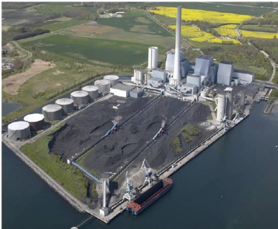
Studstrupværket: 10 % halm tilsatsfyres til kul
